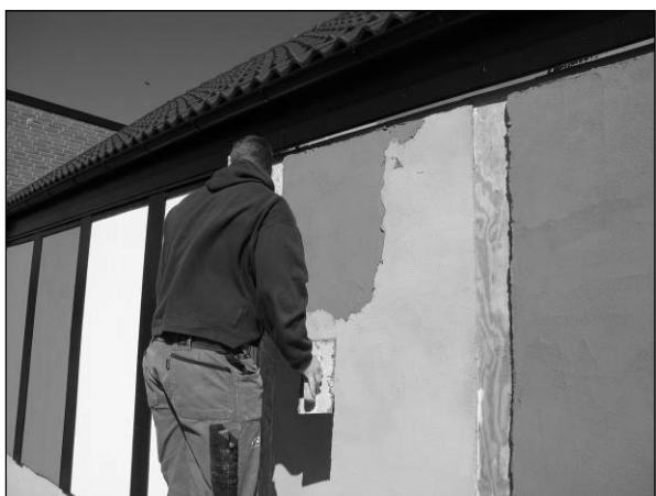
2008-04-22: Andra skiktet puts SERPO 261 EF-bruk appliceras i tjocklek cirka 1-2 mm.
