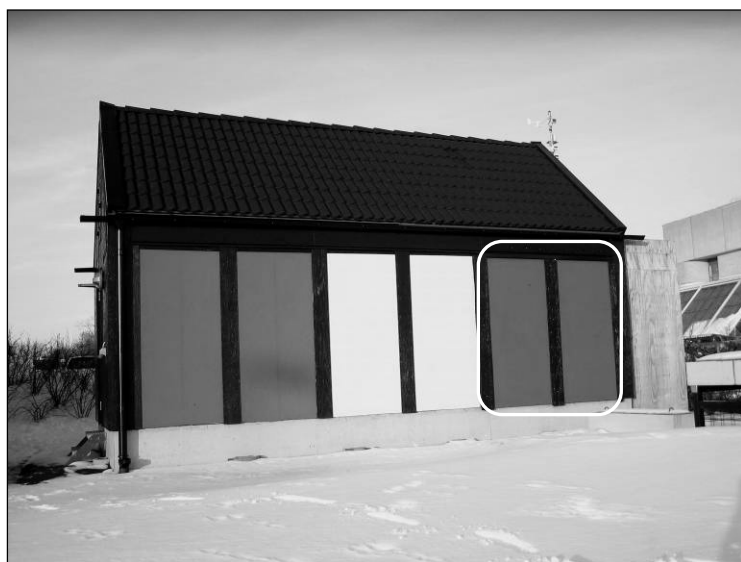
Figur 6-1 Provhusbyggnadens långfasad mot söder.
