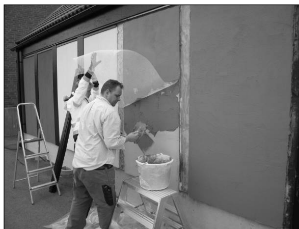
2008-04-17: Ett heltäckande glasfibernät SERPO 397 EF-nät arbetas in i det våta bruket.
