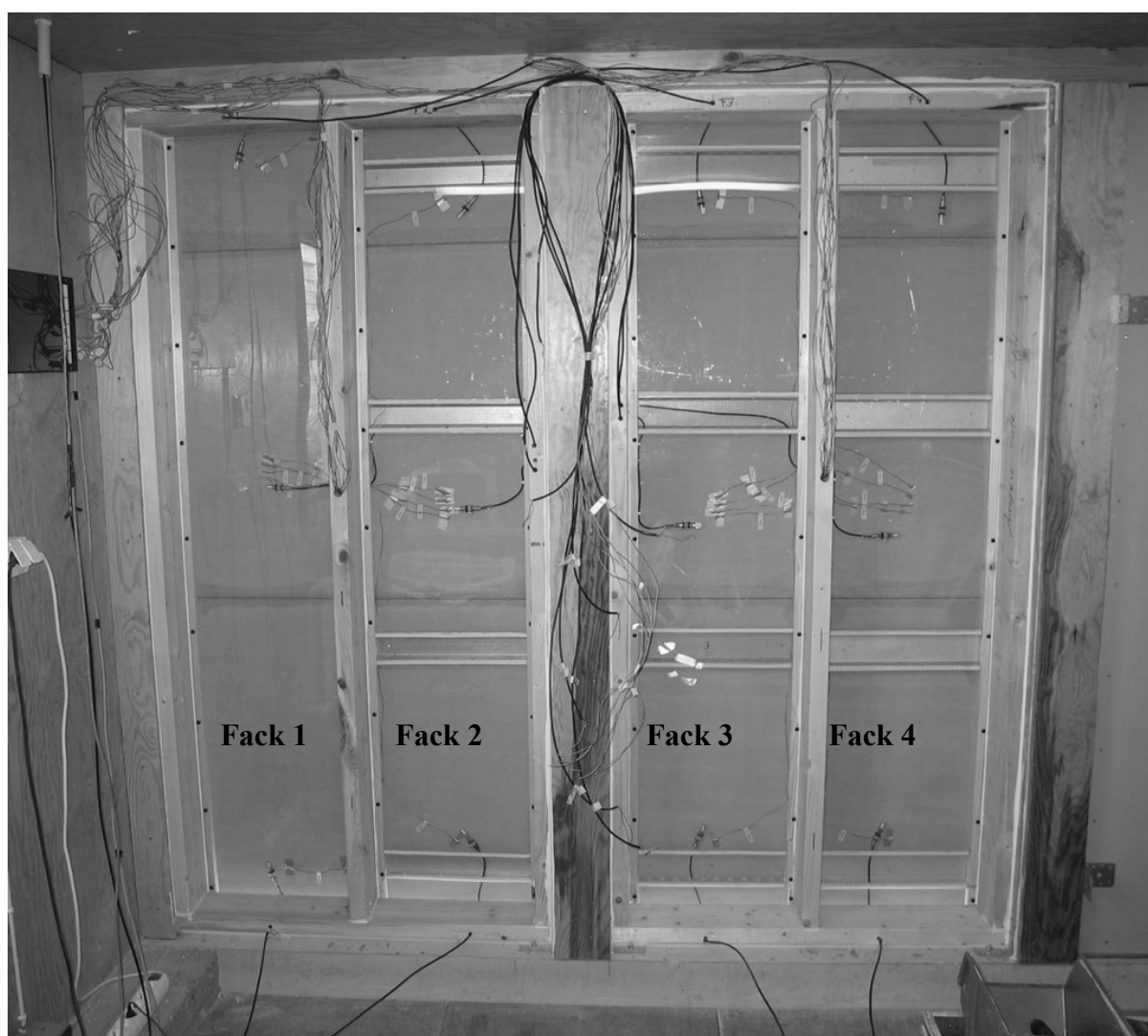
Figur 6-2 Experimentväggar med installerade givare i vy inifrån.
