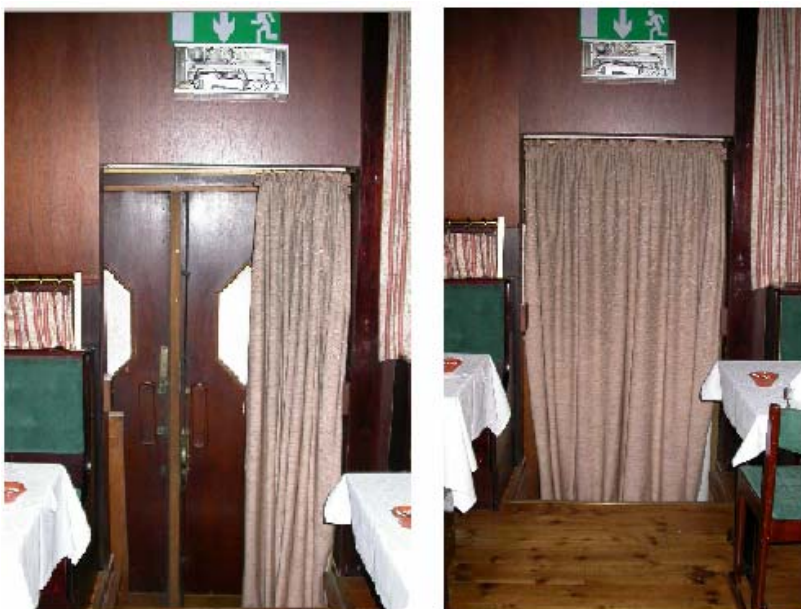
Bild 8.1 Det är svårt att hitta och identifiera en oattraktiv utrymningsväg
