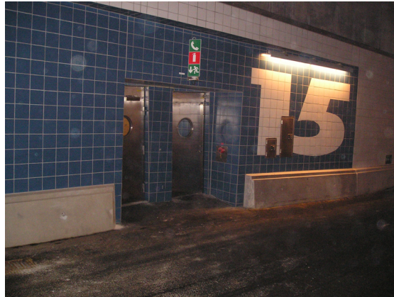
Figur 3. Ingång till en tvärförbindelse utan mellanliggande utrymme.
