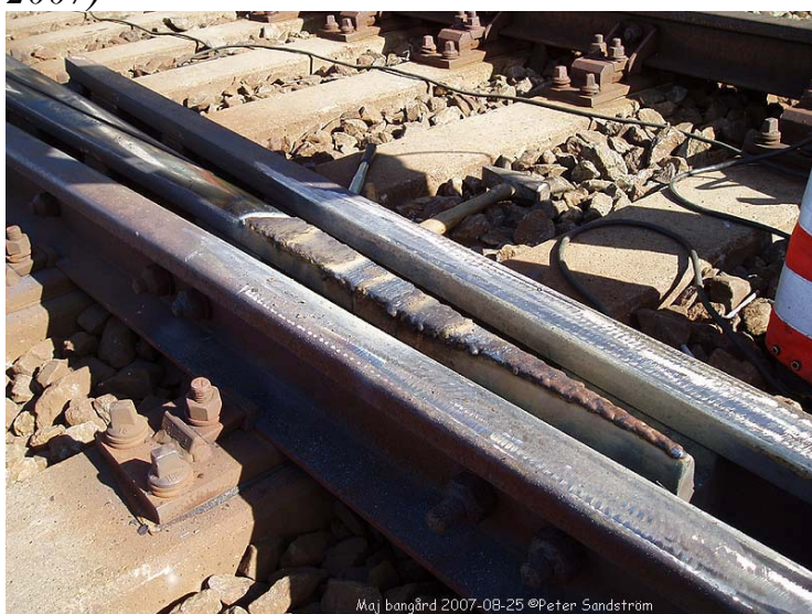
Fig. 6.1 Påläggssvetsning av korsningsspets. (Peter Sandström)
