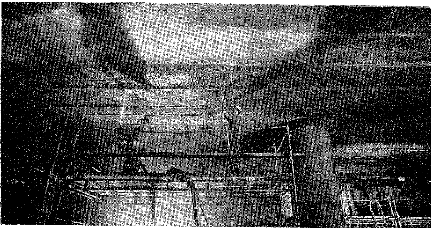
Fig 11. Pågående betongsprutning. Med hjälp av avdragningsbanor erhålls erforderligt täcksikt för armeringen och god planhet hos underytan.
