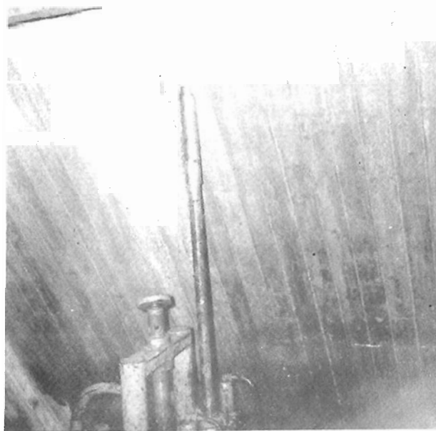
Fig 53. Storfinnforsdammen. Vertikal utborrning av provkärnor.
