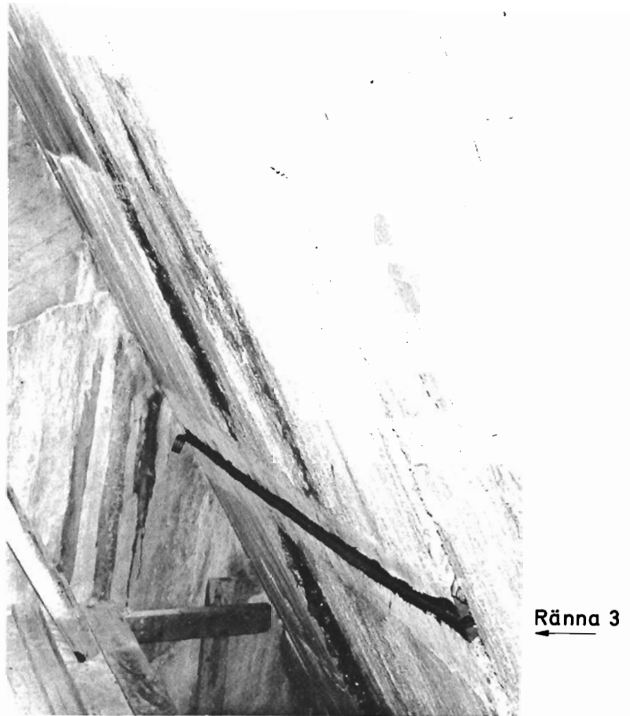
Fig 50. Storfinnforsdammen. Uppsamlingsränna 3, vid monolit 43.
