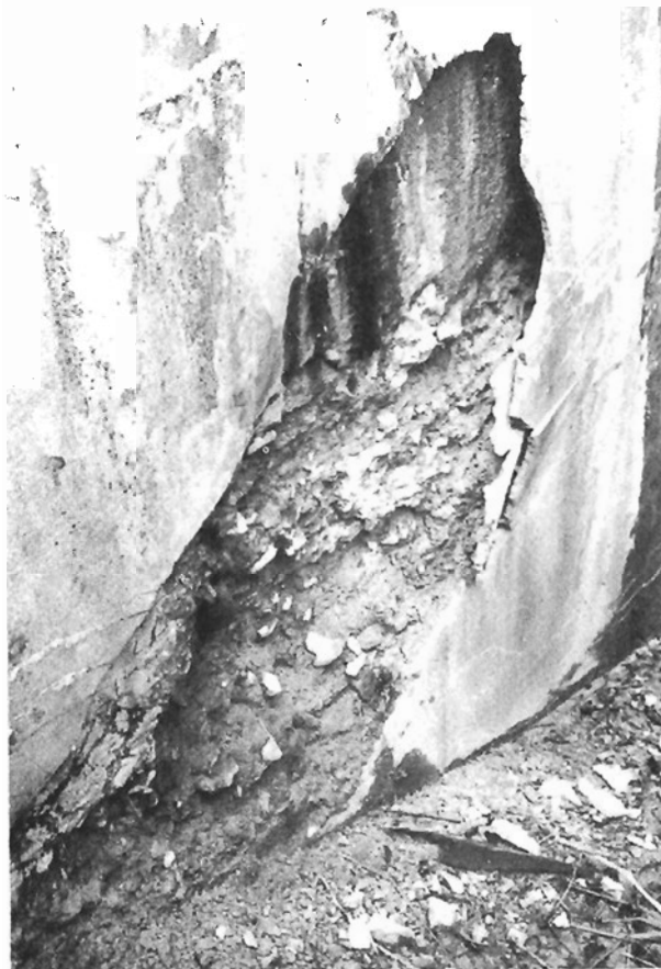
Fig 19. Majenfors. Porös, skadad betong. Armeringen i denna betong var dock utan rostangrepp.
