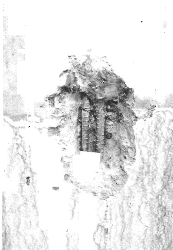
Fig 5. Storfinnforsen. Frilagda armeringsjärn vid spricka 13:3. Järnen är fria från rostangrepp.
