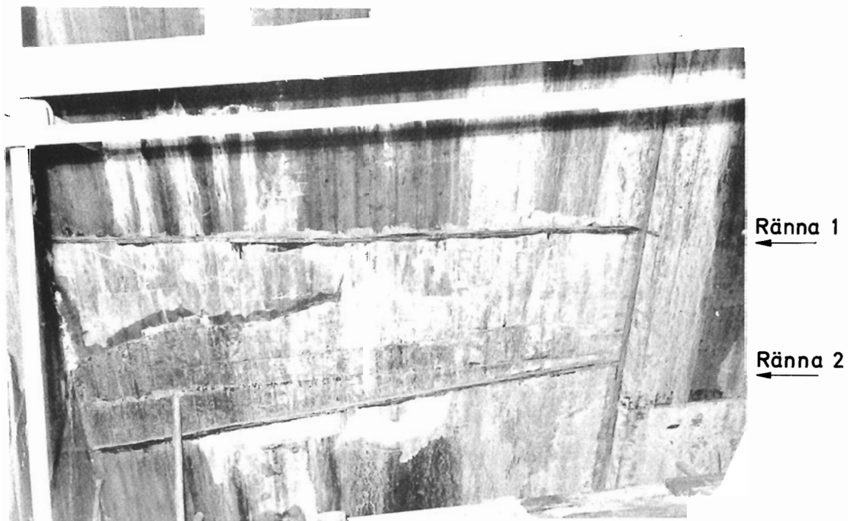
Fig 49. Storfinnforsdammen. Rännor för uppsamling av läckvatten vid monolit 47 i det inbyggda utrymmet.
