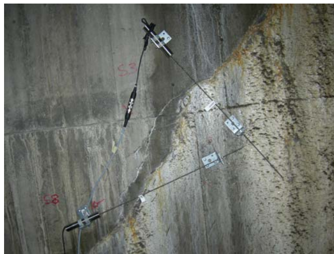
Figur 6.5 Mätning av sprickrörelser i Storfinnforsens damm år 2006 och pågående med LVDT-givare K3 och K8.
