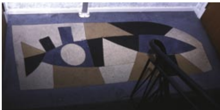
Gjutet golv i terazzo på Vasaloppsvägen, Västertorp (1949)
