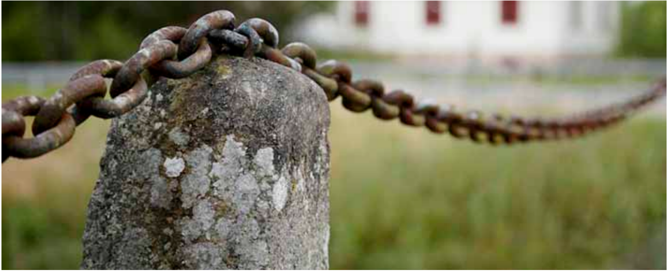
Detalj av broräcket vid stenvälsbron vid Örsled.
