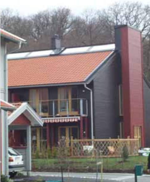
Figur 7.13 Sydsidan av ett av gavelhusen till radhusen i Lindås. På taket finns takintegrerade solfångare samt ett takfönster per bostad.
