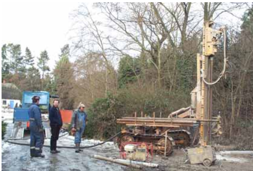
Figur 14.2 Borrning av bergvärmebrunn till villasystem.
