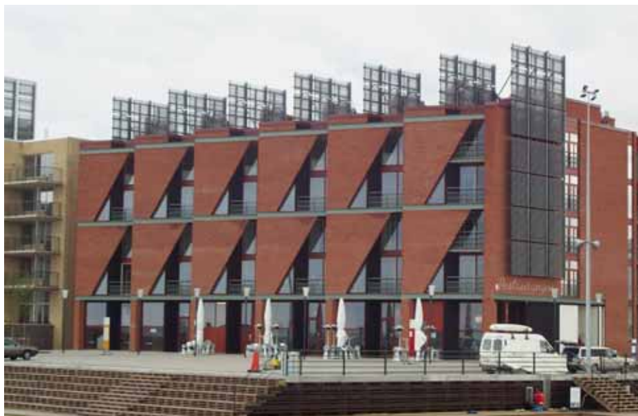
Figur 9.10 Användning av vacuumrörsolfångare, dels på fasad och dels vertikalt placerade ovanför taket som utsmyckning, på Bo01-området (Västra hamnen) i Malmö.
