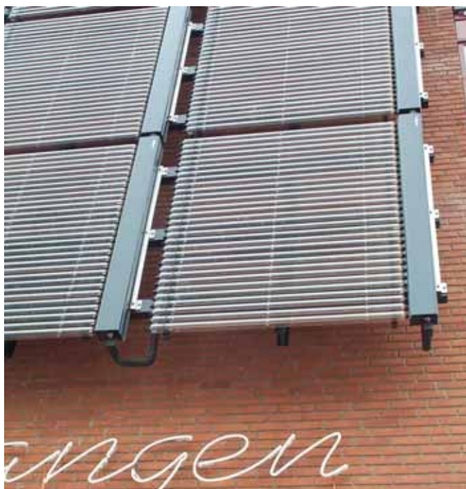
Figur 9.11 Fasadmonterade vacuumrör, detalj från byggnaden i figur 9.10.
