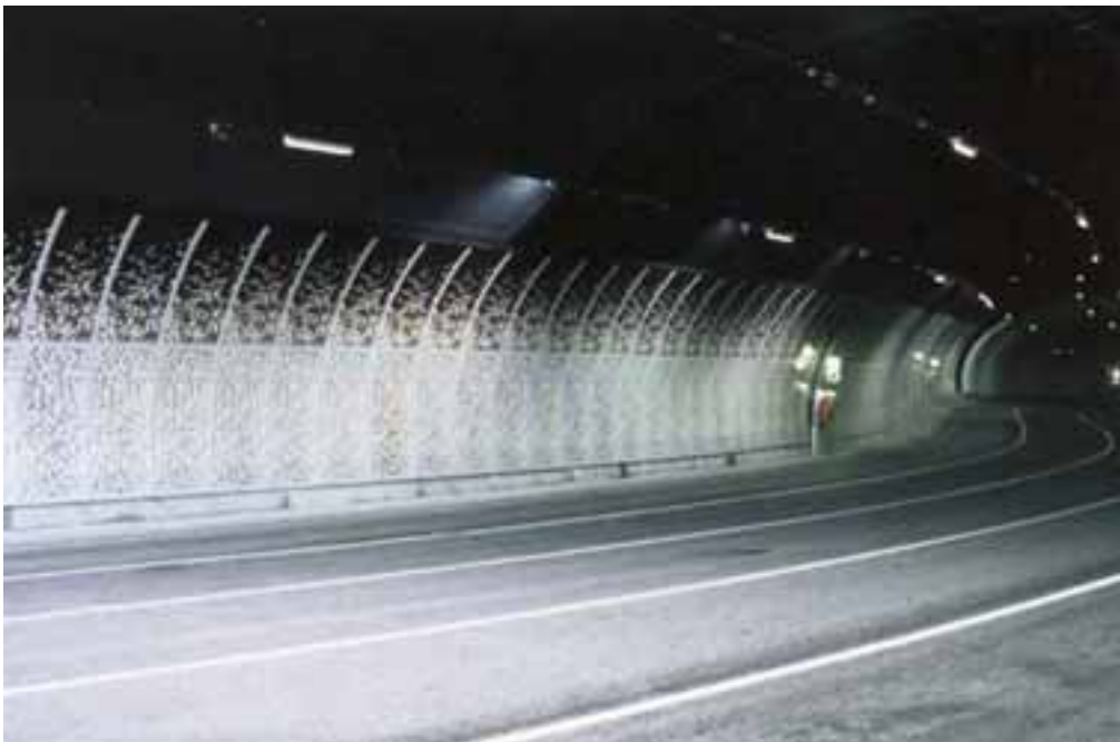
Figur 2: Mannheller tunnel og ferjekai. Kunstnerisk utsmykking av Marianne Heske. Foto: Kurt Skagen
