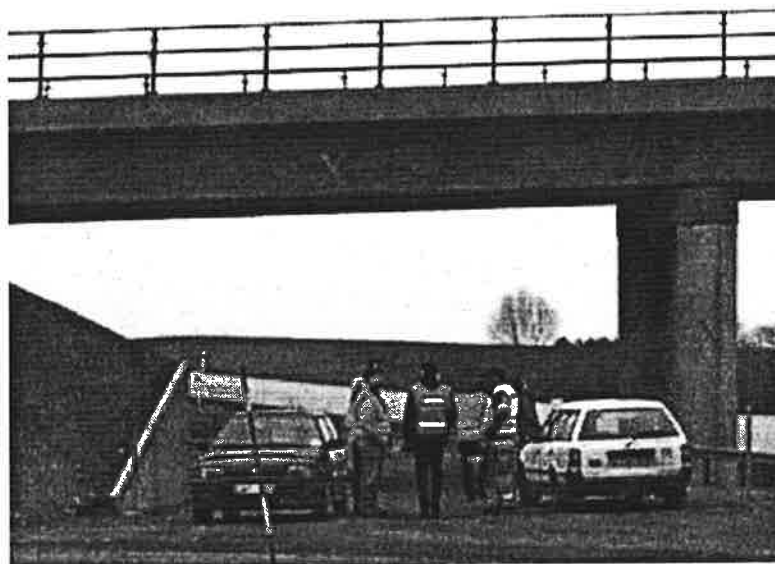
Figur A3 Den undersökta spannet, d.v.s. spann 3. Borrkärnorna har tagits från det tråg och den pelare, närmast i bilden, som är markerade med X i bilden.
