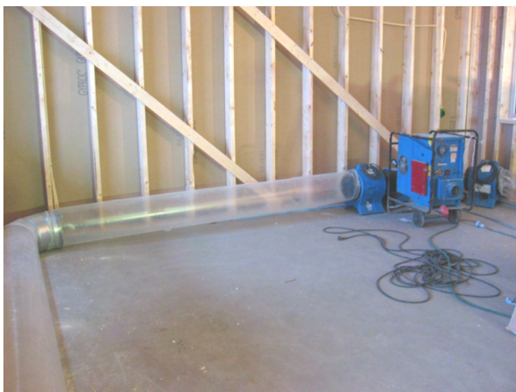
Figur 3-14 Riktad anblåsning på syllar med torr och varm luft. Bildkälla: Skanska Sverige AB
