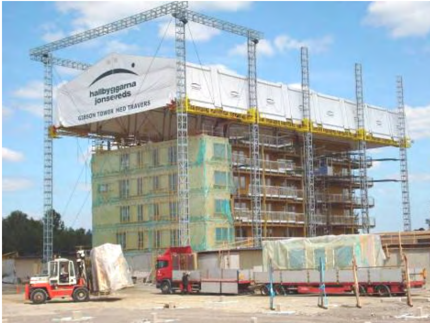
Figur 3-12 System Gibson Tower. Självklättrande skjutbart WPS på fackverkstorn. Bildkälla: NSS Sverige AB (2008)
