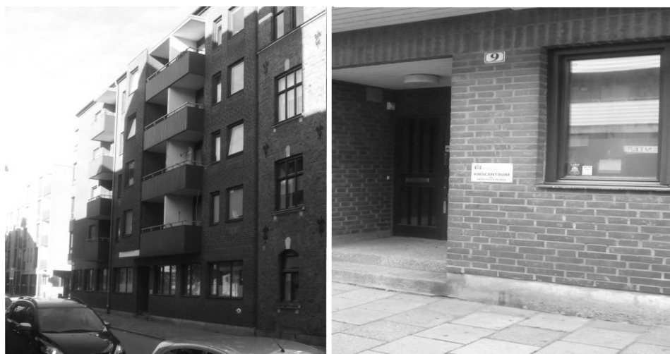
Bild 4 Kriscentrum för barn och ungdomar i Malmö
