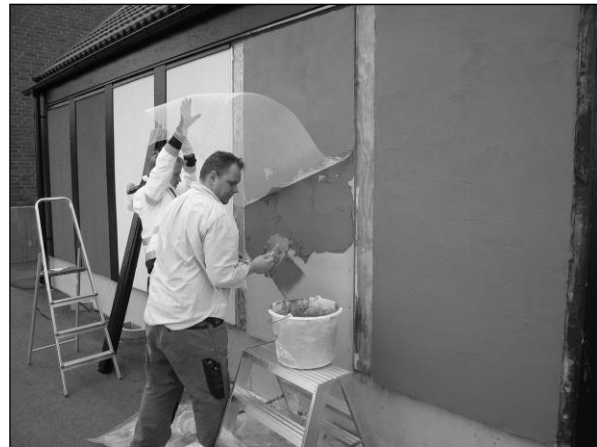
2008-04-17: Ett heltäckande glasfibernät SERPO 397 EF-nät arbetas in i det våta bruket.
