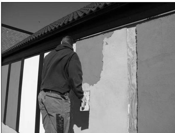
2008-04-22: Andra skiktet puts SERPO 261 EF-bruk appliceras i tjocklek cirka 1-2 mm.
