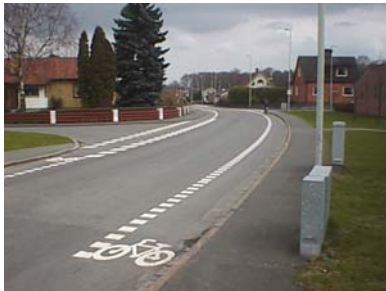
Foto 4:4: Ållingavägen, Kristianstad 7 meter bred lokal/upsamlingsgata, utan mittlinje, ÅDT 1 600 1,15 meter brett cykelfält, avgränsat med 0,2 meter bred cykelfältslinje Cykelöverfartsmarkering förbi sidogator ( ej på bild )
