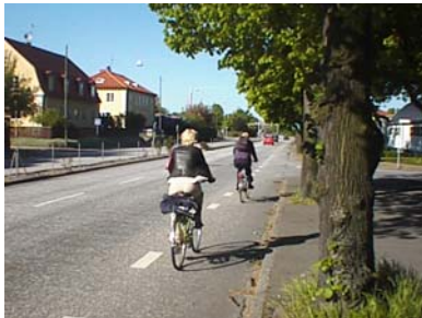
Foto 4:5: Erikslustvägen, Malmö Huvudgata med mittbarriär, 8 meter bred på var sida, ÅDT 10 000, 1 400 cyklister per dygn 1,85 meter bred vägen, "cykelutrymme", avgränsat med 0,2 meter bred kantlinje Spärrlinje inför korsningar ( ej på bild ), kantlinje fortsätter förbi sidogator och busshållplatser ( ej på bild )
