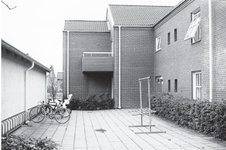
Figur 11.10 Cykelparkeringen har placerats på utsidan av husen, i de utrymmen som arkitekten kallade för "nyttogårdar". Fotot taget 981001.
