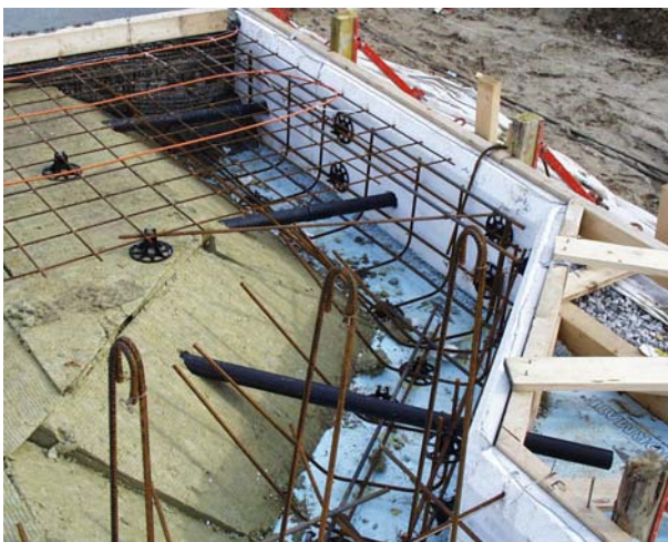
Figur 9.9 Montering av inblåsningsrör för HP-torkning.
