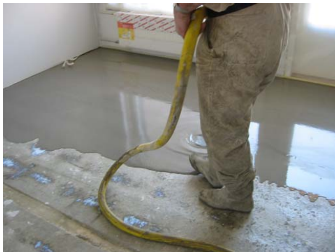
Figur 7.1 Applicering av avjämningsmassa på HD/F-bjälklag. (Foto Anders Anderberg 2003)
