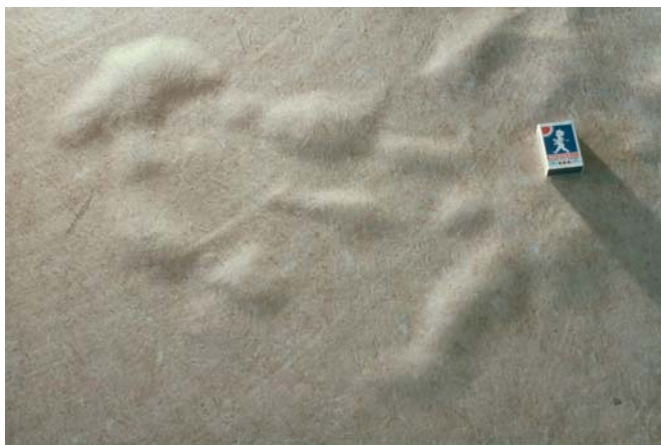
Figur 1.1 Mattlossning till följd av kemisk nedbrytning av limmad plastmatta. (Foto Leif Erlandsson 1976)
