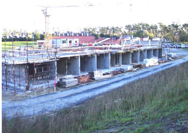
Figur 9.2 Hotelldelen under bygnation. Plattbärlaget har just monterats.
