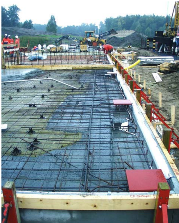
Figur 9.16 Gjutning av voter och kantförstyvningar i betong K 60.
