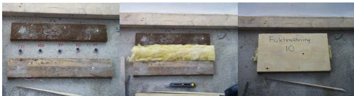
Figur 9.15 Skydd av mätpunkter under byggtiden.
