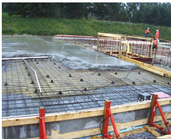
Figur 9.7 Gjutning av voter och kantförstyvningar dagen före gjutning av bottenplattan.
