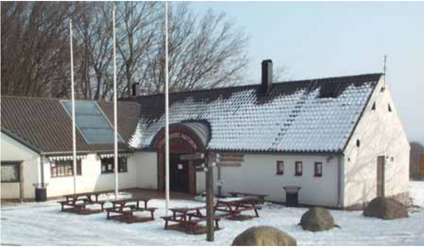
Figur 9.15 Takintegrerad solfångare infälld i tegeltaket på Naturum, Stenshuvuds Nationalpark.
