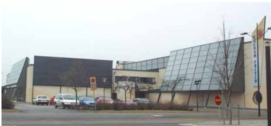
Figur 9.9 Fasadmonterade solfångare mot söder och öster på Kockum Fritid i Malmö.
