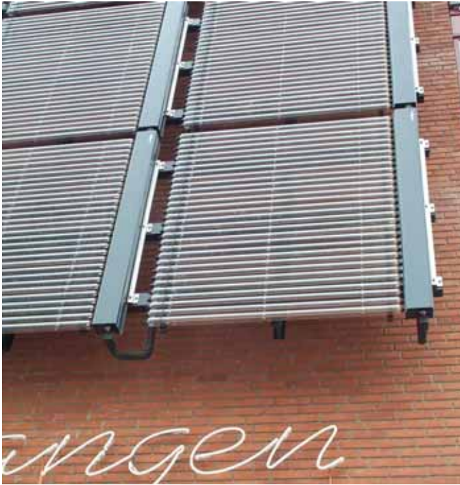
Figur 9.11 Fasadmonterade vacuumrör, detalj från byggnaden i figur 9.10.
