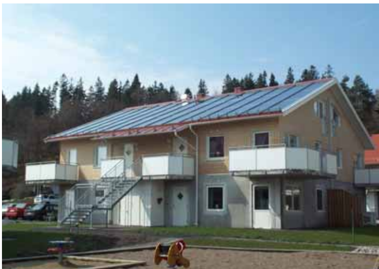
Figur 8.4 Takintegrerade solfångare på nya bostadshus uppförda av Eksta kommunala bostadsbolag, Kungsbacka.
