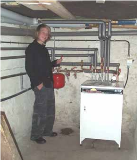
Figur 14.1 Villavärmepump där inkoppling av solvärmesystem och markvärmekrets är integrerade i värmepumpens ytterhölje.
