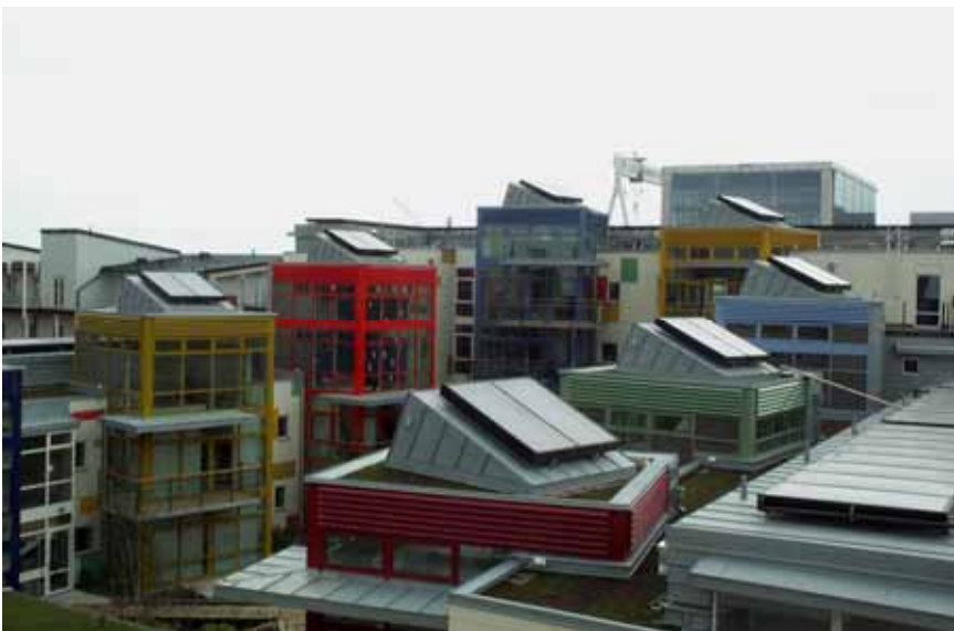
Figur 9.14 Solfångare placerade på tak på Bo01-området i Malmö. Energileverantören äger solfångarna och husägarna upplåter plats på taken till solfångarna.
