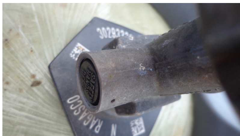
Figur 29. Säkerhetsventil PC5.
