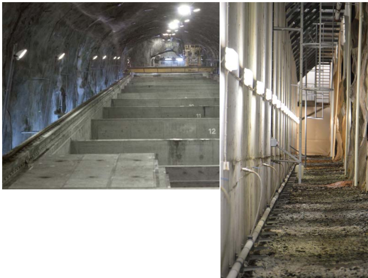
Bild 1. Bergrummet 1BMA med dess betongkonstruktion (tv) och mellanrummet mellan betongkonstruktionen och berget (th) som kommer att fyllas med makadam. Foto SKB.
