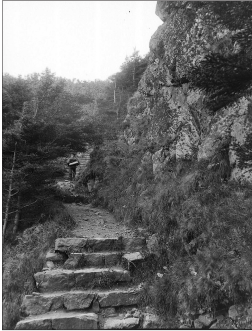
Fig. 37. Anläggningsarbete vid Josefinelust (foto: Peter P. Lundh, © Höganäs museum).
