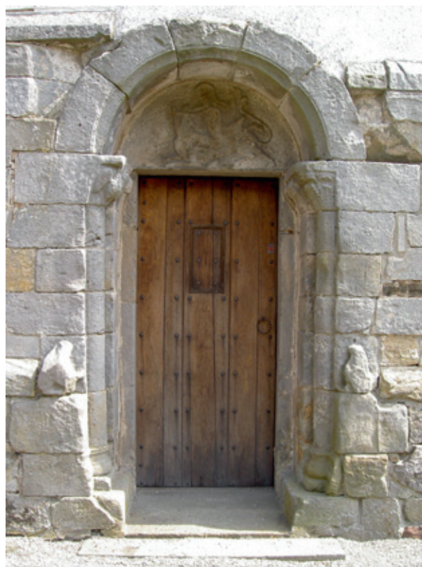
Fig. 9. Västportalen till förhallen. Foto Jes Wienberg, september 2010.
