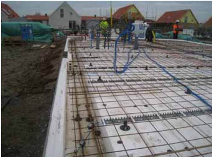
Figur 21. Kantförstyvning med samtliga noder
