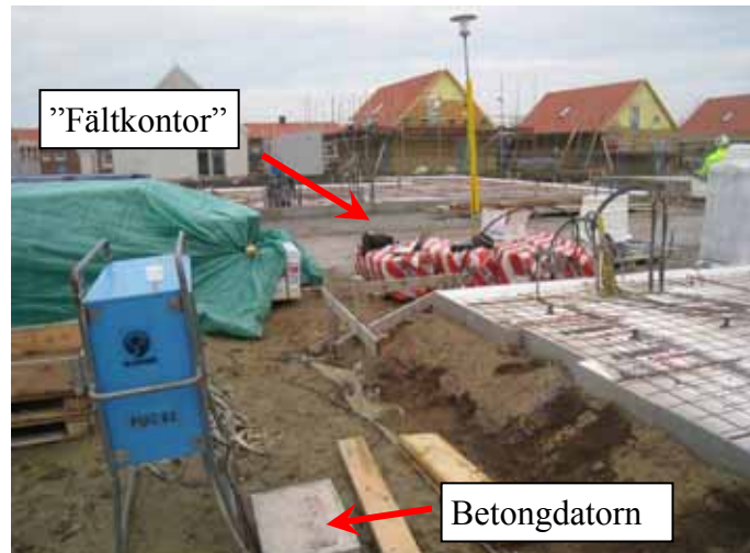
Figur 22. BetongDatorns centralenhet invid elcentral
