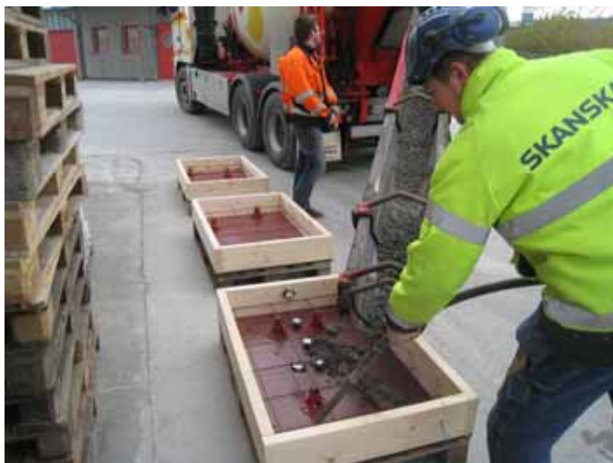
Figur 10. Gjutning med betongrännor samt vibratorstav
