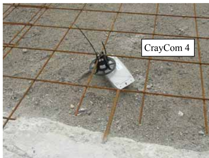
Figur 41. Placering av CrayCom 4 under "tassen"..
