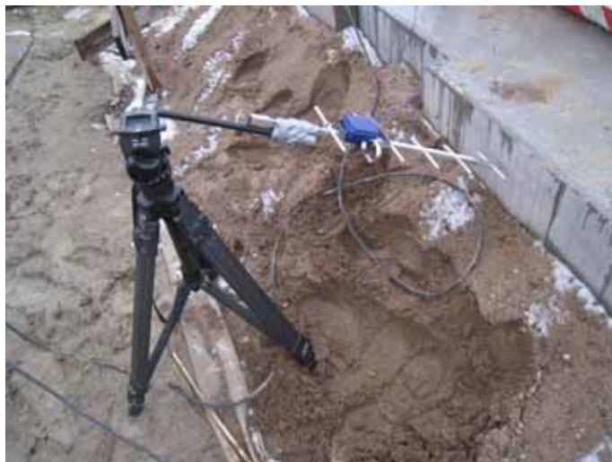
Figur 26. Riktantenn monterat på kamerastativ.
