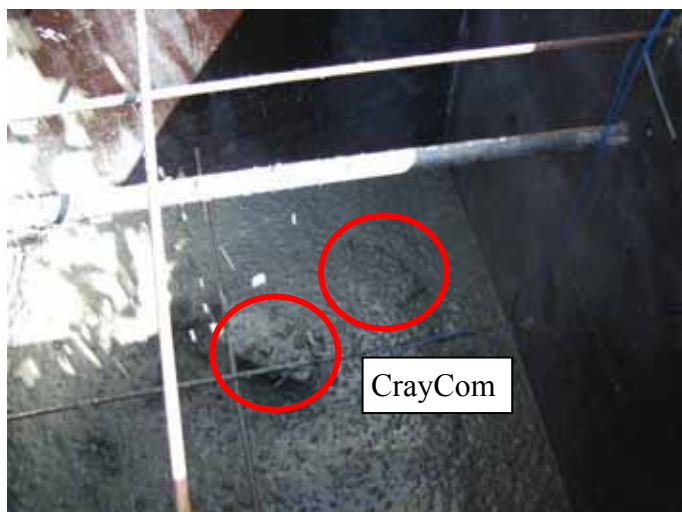
Figur 33. Ingjutning av mätutrustningen.
