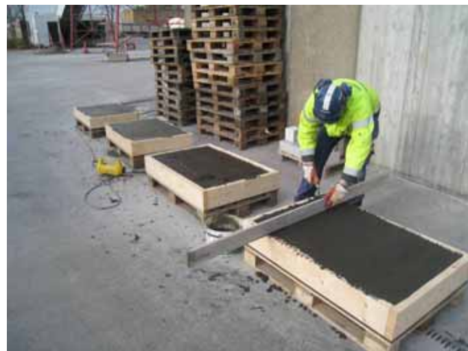
Figur 11. Avdrag därefter täckning och brädrivning av yta
