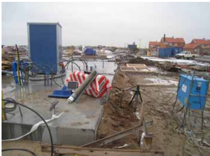
Figur 25. Avläsning 2009-01-23 med riktantenn.
