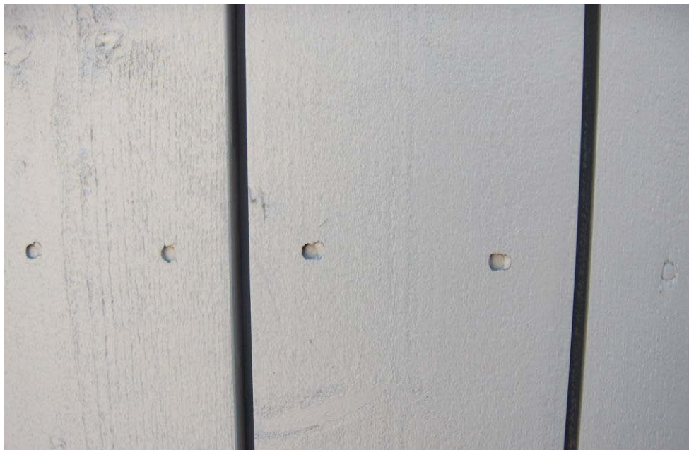
Figur 2 Andra exempel på några olika djupt inslagna spikar
