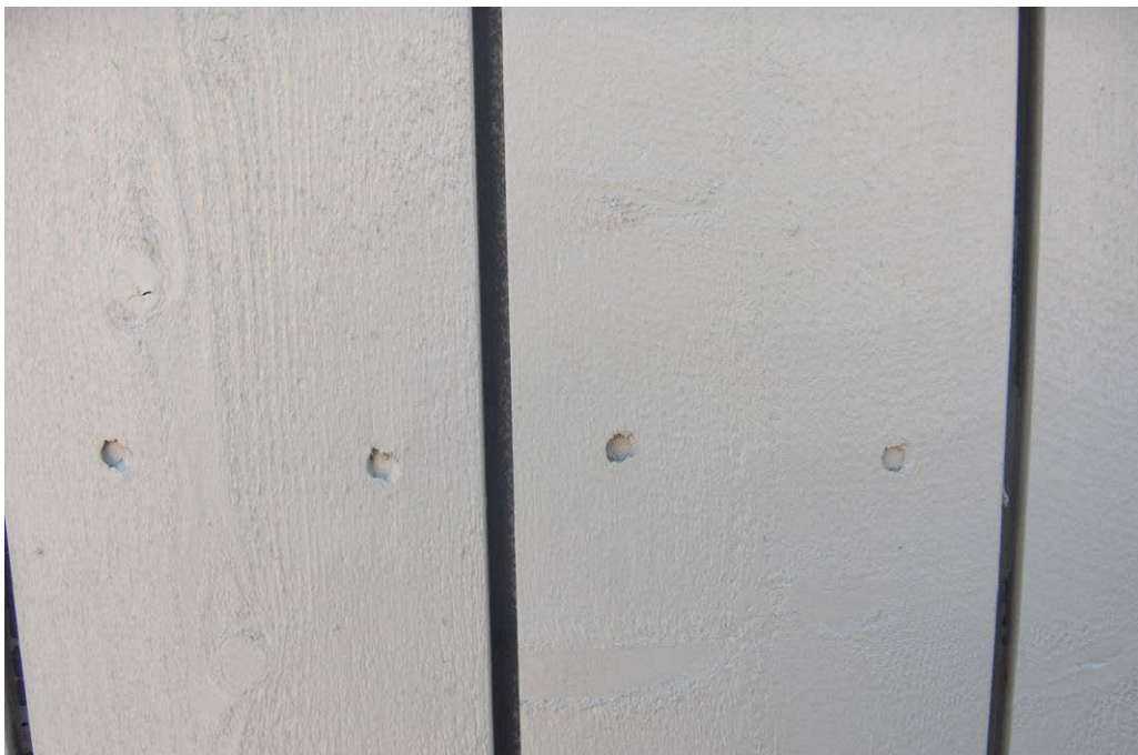
Figur 3 Parvisa spikhål som hamnat på olika höjd, vilket syns eftersom spikhålen syns.
