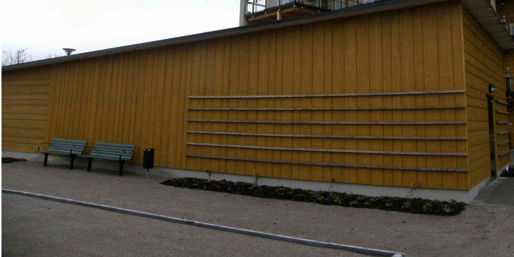
Figur 35 Liggande och stående panel på samma fasad. Djupa spikhål syns knappt på detta avstånd.
