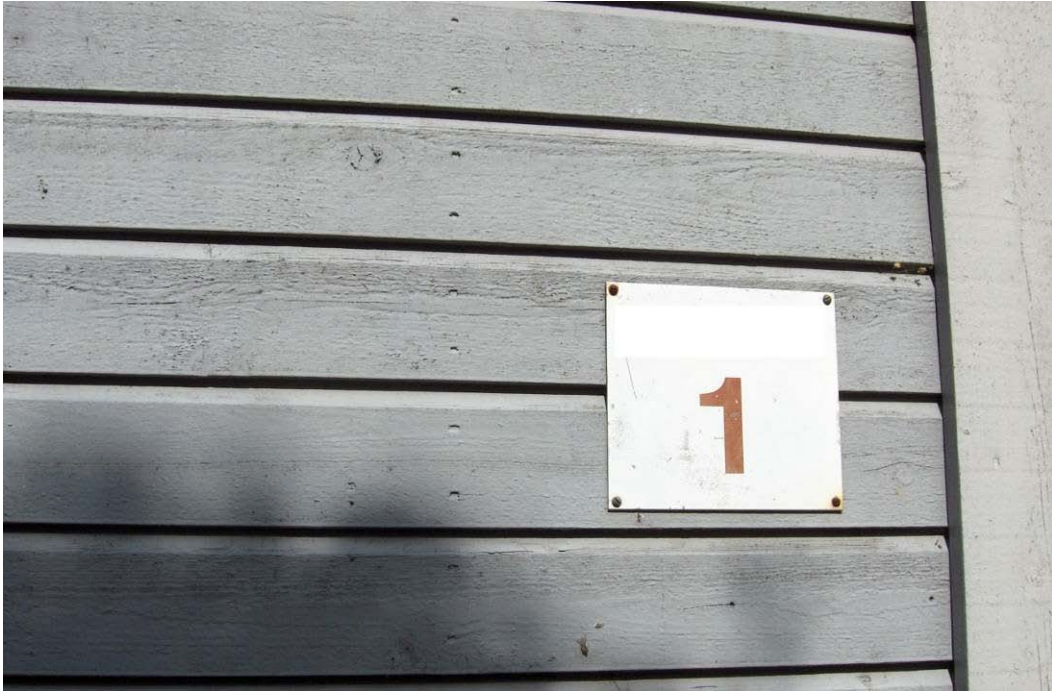
Figur 21 Djupa spikhål exakt i lod på horisontella panelbrädor. Avstånd till ovankant varierar dock, vilket syns tydligt.
