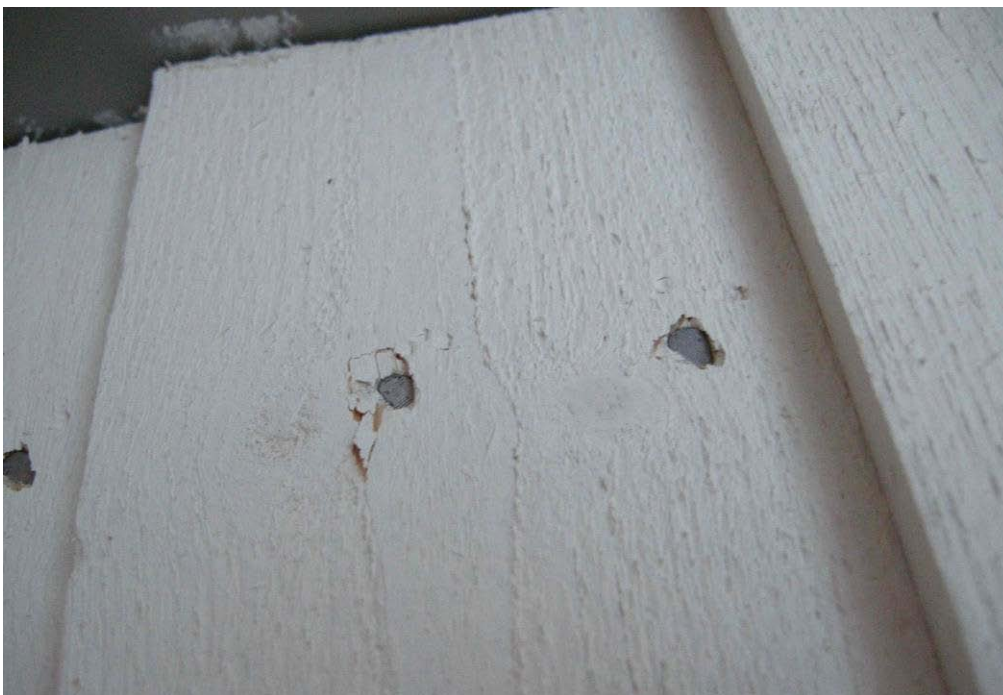
Figur 25 Djup spikning där intilliggande panyta skadats intill kvistar.
