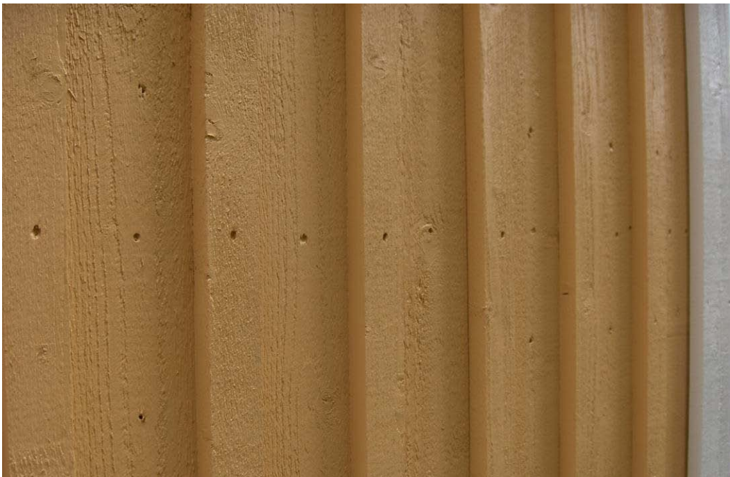
Figur 8 Närbild av fasaden i figur 7, med extra djupa spikhål.
