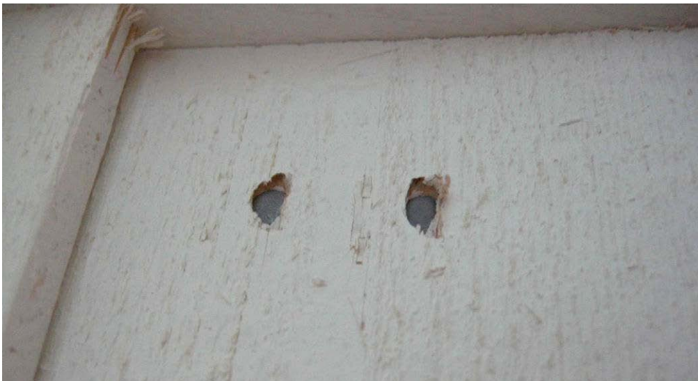
Figur 24 Djupa spikhål före färdigstrykning där det syns tydligt hur ändträ blottats i spikhålen.
