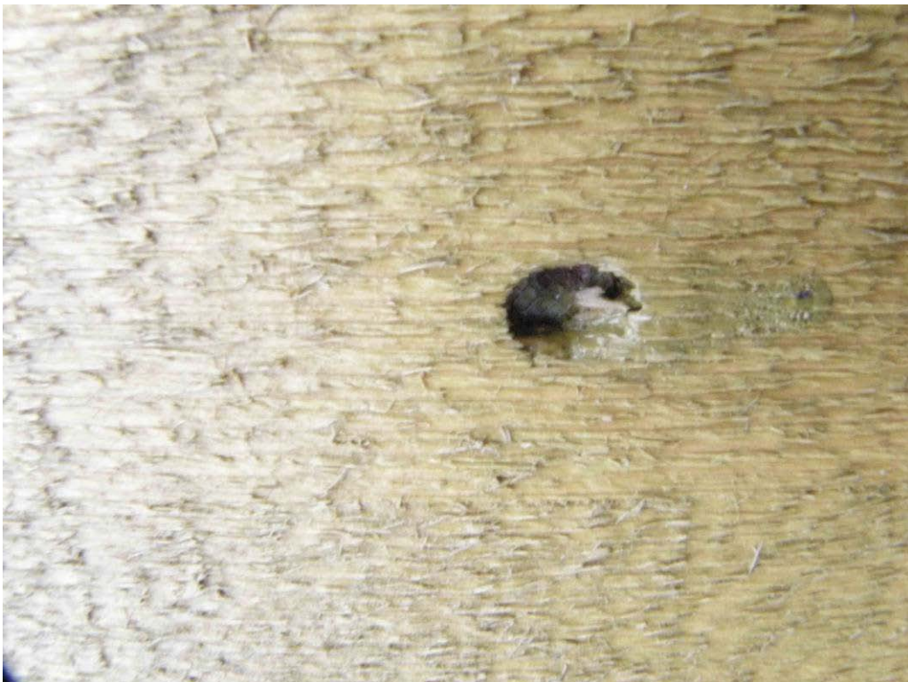
Figur 38 Mycket djupt spikhål i liggande panel.
