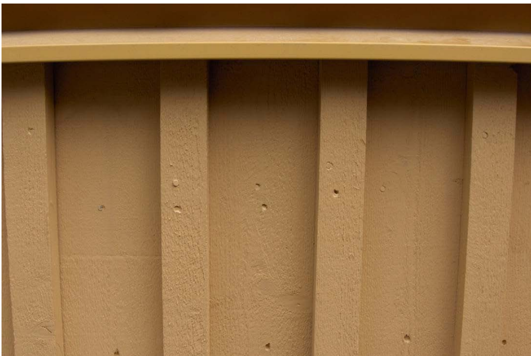
Figur 10 Spikhål som sitter ojämnt i höjdlid och inte alltid centriskt. Några spikar är inslagna exakt i nivå med panytan medan någon t o m inte är tillräckligt inslagen.
