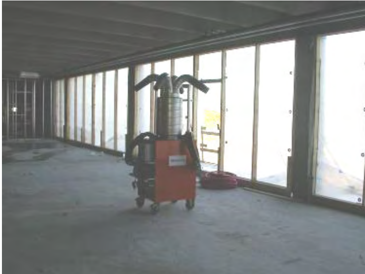
Figur 3-1 Provisorisk vägg på plan 2 uppsatt innanför det glasparti som skulle monteras senare. Bildkälla: Skanska Sverige AB
