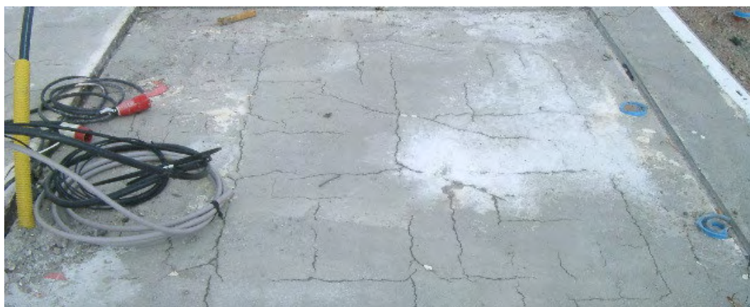
Figur 3-4 Plastiska krympsprickor orsakade av bristfällig fukthärdning av ytan vid gjutning med självtorkande betong. Bildkälla: Skanska Sverige AB
