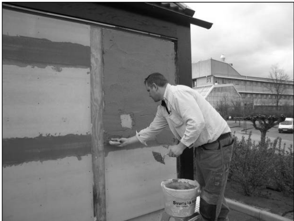
2008-04-17: Det första skiktet puts SERPO 261 EF-bruk appliceras i tjocklek cirka 5-7 mm.
