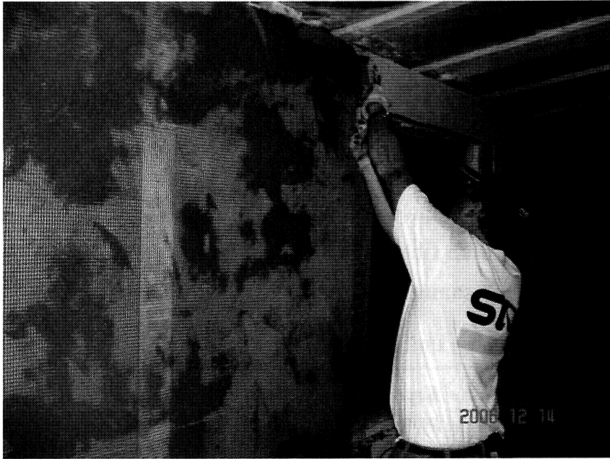
FIGUR 5. Montering av glasibernät i system 5.
