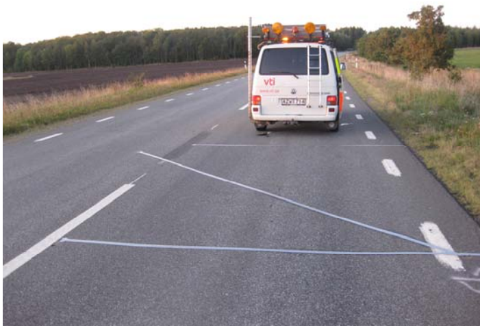
Figur 3-4 Exempel på koaxialkabelutläggning i Skåne (mätplats 1c)
