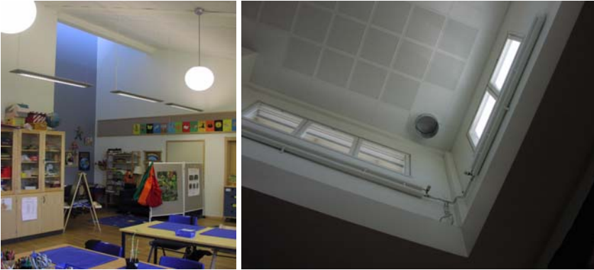
Figur 6.10 I detta klassrum förs frånluften bort via takplacerade fönster och kanaler i "schaktet" med blå fond vägg. Placeringen av schaktet reducerar risken för drag vid bänkarna.
