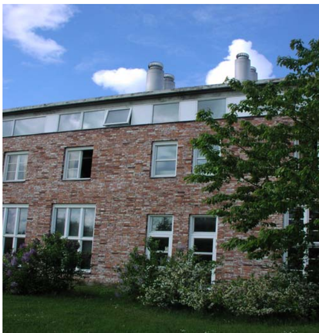
Figur 6.2 Östra Torn skolan i Lund. Uteluften tas in via markrör och tillförs klassrummen via don i golvnivå. Frånluften förs bort via takplacerade kanaler i vilka ett spjäll som styrs automatiskt är placerat.
