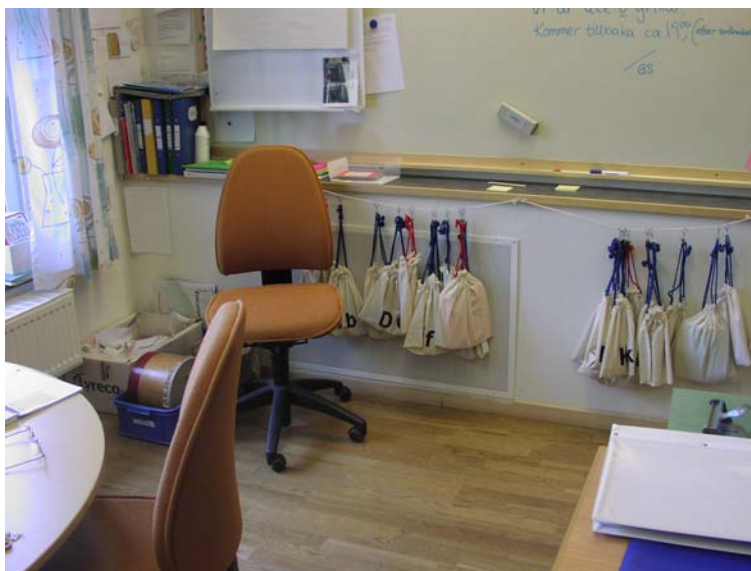
Figur 6.7 I detta klassrum där tygpåsar placerats framför tilluftsdonen reduceras även möjligheterna för tilluften att passera in i klassrummet.
