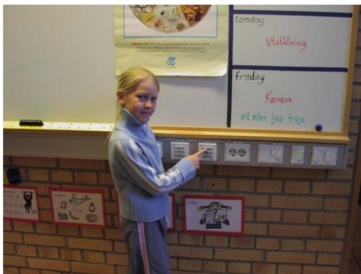
Figur 6.13 Här visar en elev hur frånluftsfönstren skall styras med hjälp av kontrollpanelen vid tavlan i detta klassrum.
