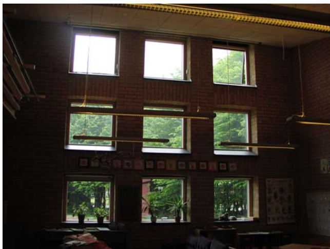
Figur 6.12 Om frånluften i ett klassrum endast kan föras bort via de översta fönstren placerade mot ett väderstreck kan olämpliga driftsfall uppstå.
