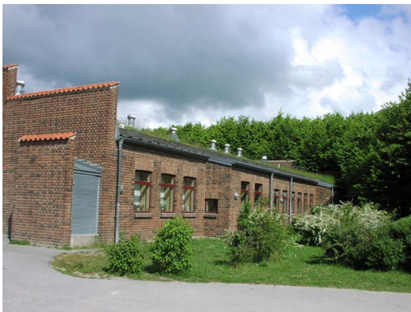
Figur 6.4 Vindspelet på Klostergården i Lund. Tilluften passerar en kulvert innan den förs in via golvplacerade don. Frånluften förs bort via högt placerade fönster i varje rum.
