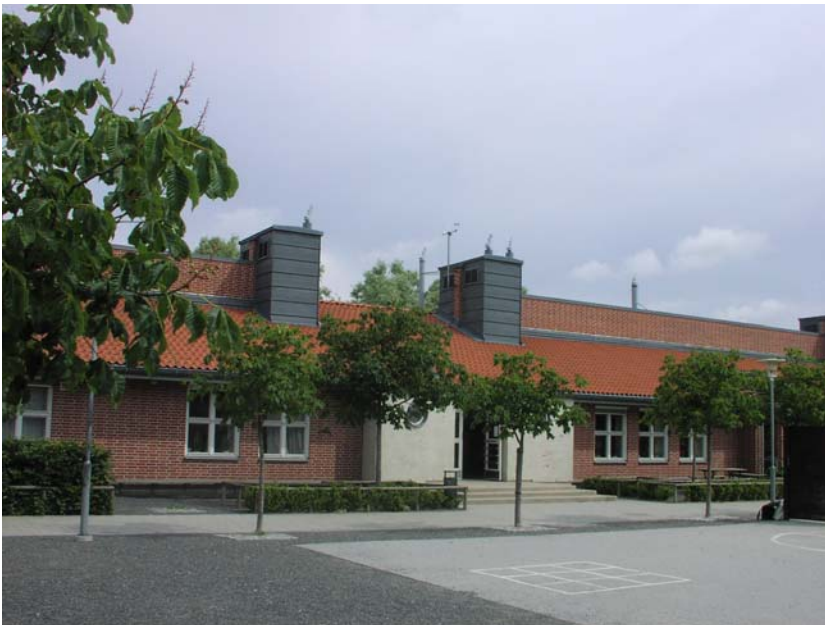
Figur 6.1 Risebergaskolan i Malmö. Tilluften passerar via jordrör samt en betongkulvert och förs in i rummen via väggplacerade don. Frånluften förs bort via takplacerade fönster. Vid högre utetemperaturer kan en hjälpfläkt sattas i drift i kulverten.
