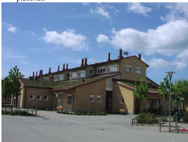
Figur 6.3 Ängslättsskolan i Bunkeflo utanför Malmö. Uteluften passerar markrör och en betongkulvert innan tilluften tillförs via golvplacerade don. Tilluften till klassrummen placerade närmst markrörerna passerar endast en kort sträcka av kulverten. Frånluften förs bort från rummen via takplacerade fönster samt kanaler med spjäll.
