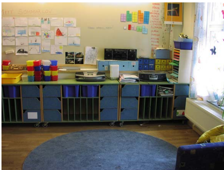
Figur 6.9 I detta klassrum finns två tilluftsdon i golvnivå. Ett av dem är placerat bakom skåpen.
