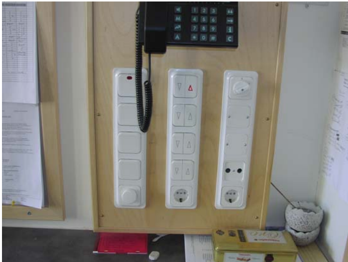
Figur 6.11 Den manuella regleringen av frånluften sker via en panel placerad vid tavlan. När man står vid tavlan ser man inte in i schaktet och kan inte se vilket fönster eller kanal som öppnas eller öppningsgraden. Angivelse av respektive öppning på panelen hade möjligen underlättat den manuella styrningen.
