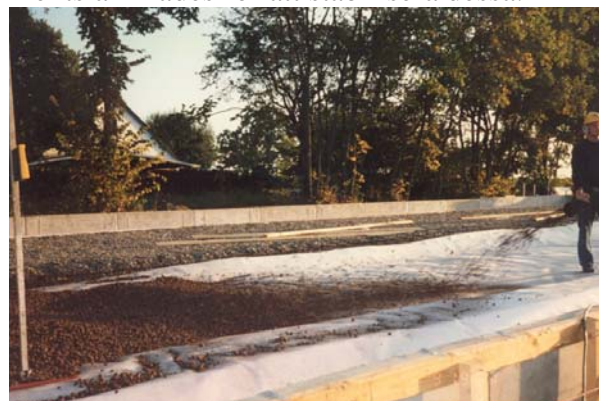
Figur 1.4 - Utblåsning av 0.30 m lättklinker. Foto: Göran Hedenblad, 1991 [1].
