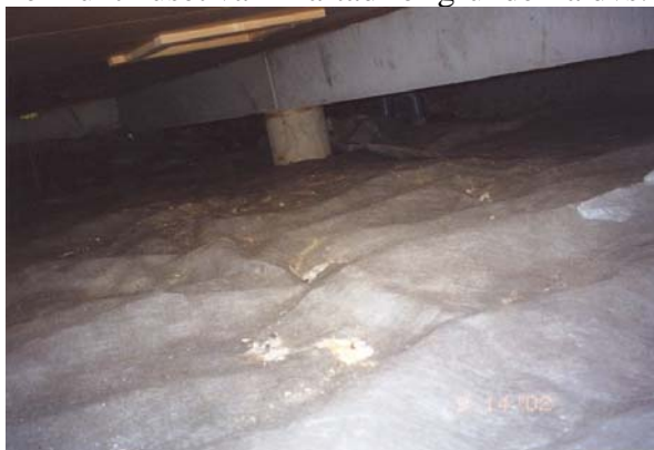
Figur 1.1 – Fiberduk ovanpå 0.30 m lättklinker (fiberduk även under lättklinkern).
