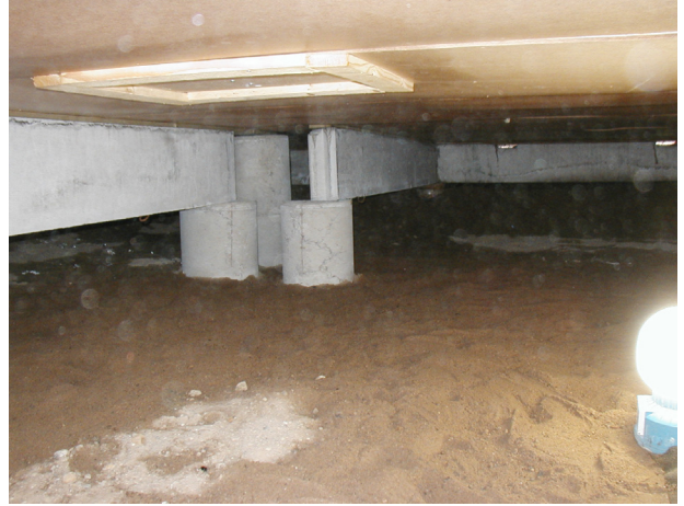
Figur 5.2 – Insteagslucka till krypgrund utan byggplastfolie, hus 6. Foto. Anders Nilsson
