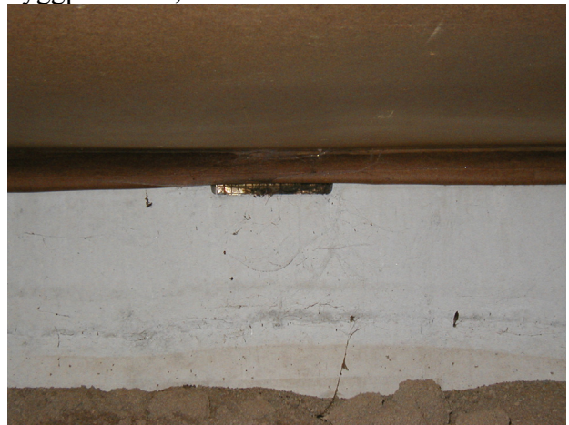
Figur 5.4 – Kontroll av ventilationsöppning i kantbalk, hus 6. Foto. Anders Nilsson.
