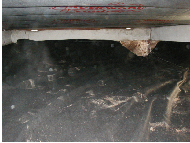
Figur 5.1 – Instiegshål till krypgrund med byggplastfolie, hus 5. Foto. Anders Nilsson.
