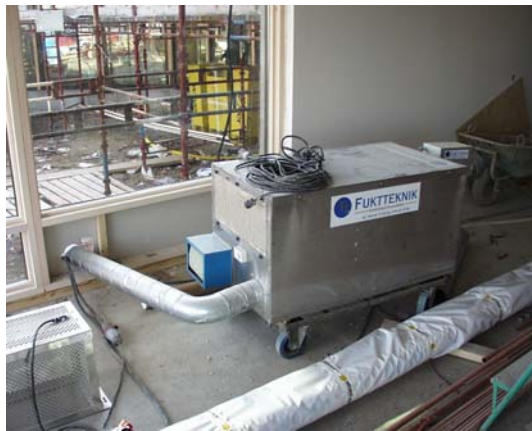
Figur 4.6 Sorptionsavfuktare
