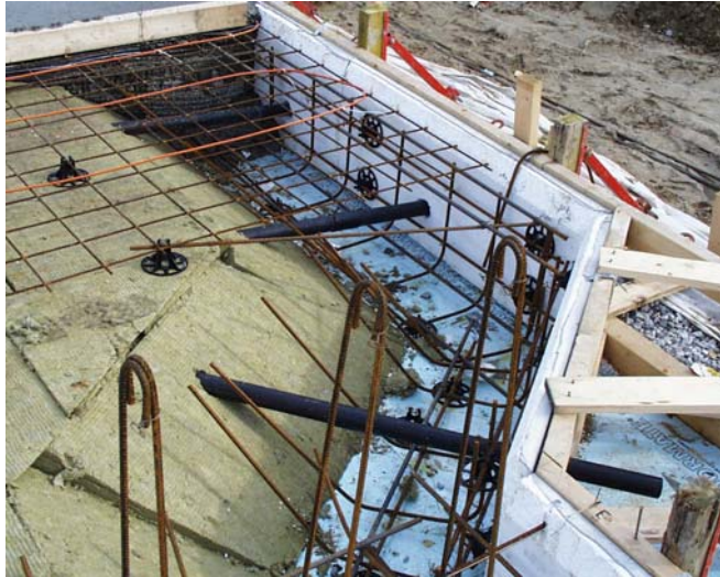
Figur 4.4 Montering av rör för HP-torkning
