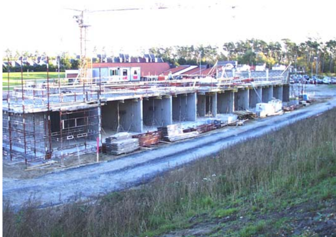
Figur 3.2 Hotelldelen under byggnation. Plattbärlaget är just monterat.
