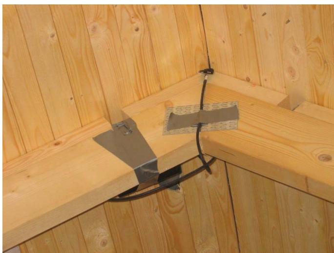
Figur 21. Nod PR #2 monterad i taknocken.
