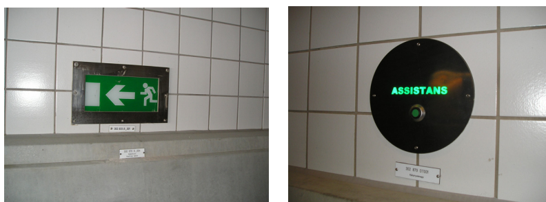
Figur 6. Vägledande markering och assistansknapp monterad i tunneln.
