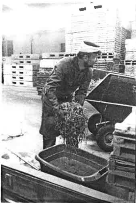
Fig 11. Ullen doppades i en cementslamma (vänster) varpå den fördelades i en form (höger). Formen fylldes till ca dubbla höjden.
