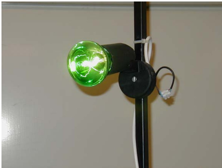
Figur 8. Armatur med grön blinkande lampa.
