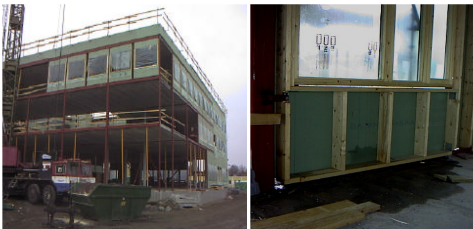
Figur 8. Stålstomme med utfackningsväggar samt utfackningsvägg av träreglar och skivor inifrån innan.
