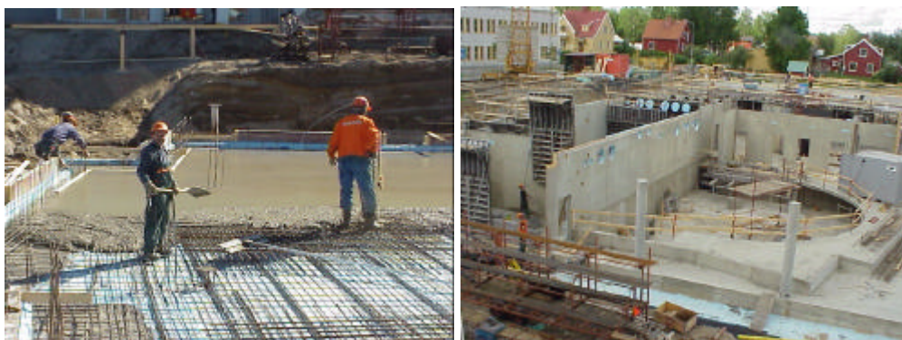
Figur 5. Gjutning av betongplatta med underliggande cellplastisolering. Betongkonstruktionen lämnas ofta oskyddad under byggskedet.
