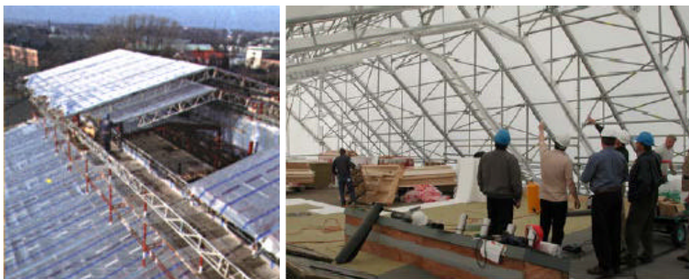
Figur 3. Väderskyddat byggande där byggobjekten helt klätts in med ett tält.
