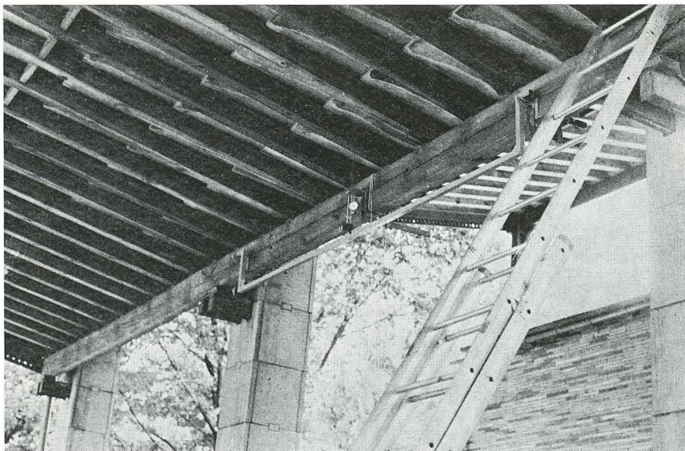
Fig. 10. Märbrygga för mätning av nedböjning på träbjälkar.
