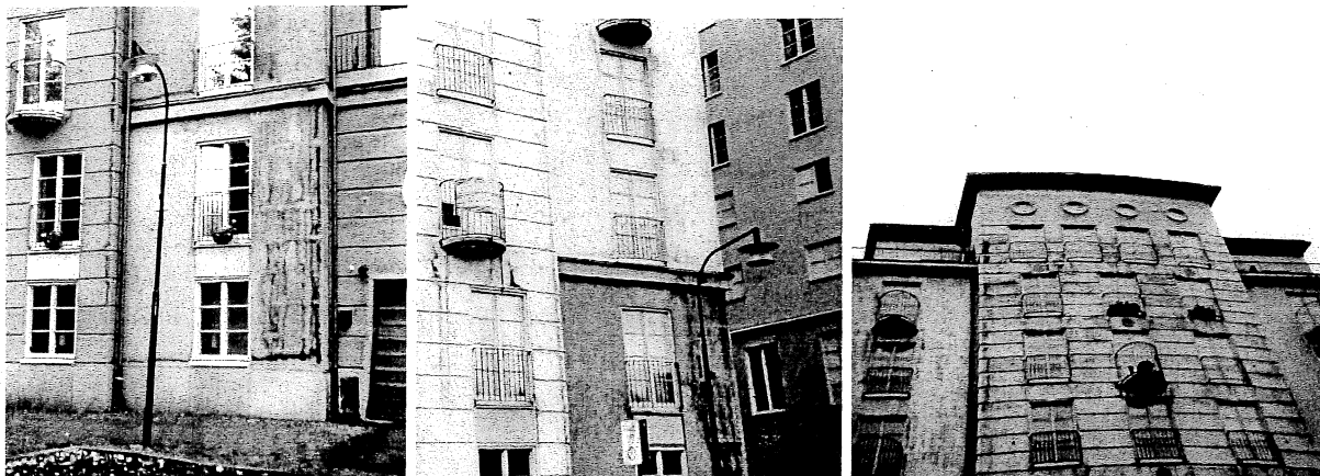
FIGUR 8. Påväxt på en ny fasad i Stockholm.
