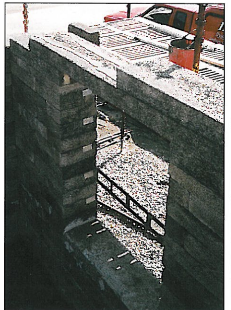
Figur 4. En armerad träullsplatta använd som balk över fönsteröppning.
