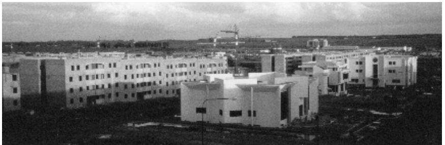
Fig. 1.1 Construction de 20.000 logements à Sala al Jadida à l'extérieur de Rabat-Salé
