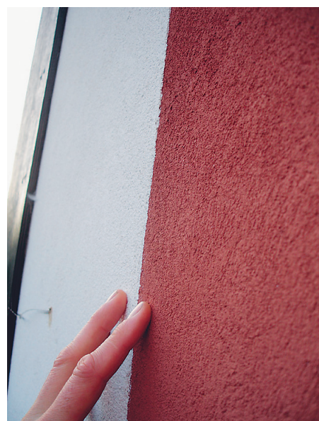
Bild 2: Vänster: kondens på ytan av fasad med tunnputs på isolering, höger: ingen kondens på fasad av tunnputs på tegel. Bild tagen en morgon i oktober månad 2007.
