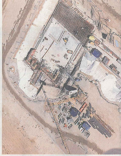
Bottenplattan till Front End Building, som ligger först vid acceleratorm. Det är här protonerna ska tas fram och ges styrfart in i acceleratorm.
