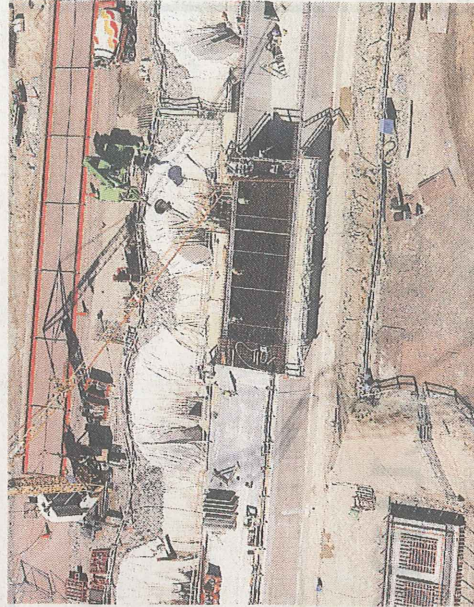
Här läggs gjutformen för ovdelen av en av acceleratorsektionerna.
