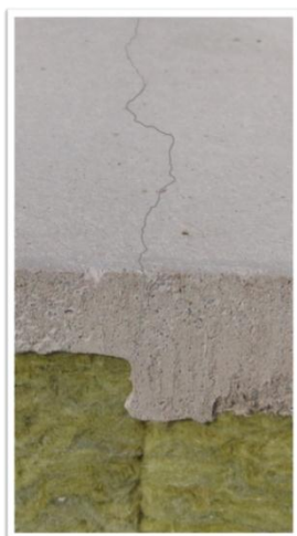
Figur 4.3.8 Spricka i oarmerad puts orsakad av geometriförändring
