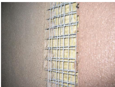
Figur 4.5.5. Provväggar, två olika bruk användes, Therm 136 (vänster) och 340 (höger). Båda var armerade med dubbelarmering. Visar en skarv mellan två armeringsnät därav flera nät.
