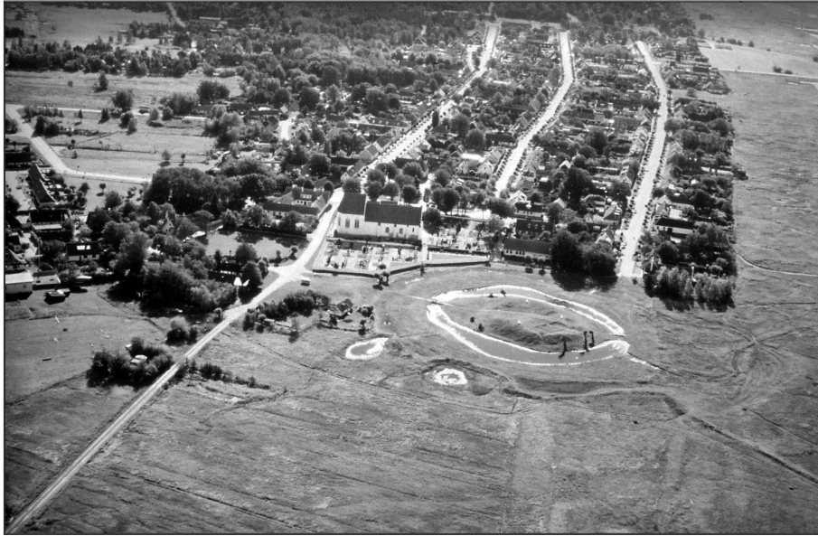
Figur 2. Flygbild över Skanör mot söder. I förgrunden syns den medeltida borgkullen med dubbla vallgravar. Sydost om borgen ligger S:t Olofs kyrka. I bakgrunden Skanörs stadsbebyggelse med de tre karakteristiska huvudgatorna. Foto: Lars Ersgård.
