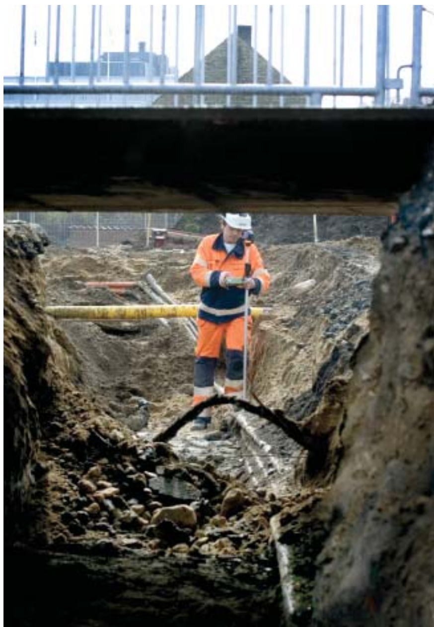
Bild 15. Byggandet av Citytunneln i Malmö, april 2005. FOTO: EL-ALAWI/SYDSVENSKAN BILD
