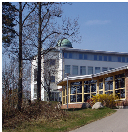
Väggaskolan, senare tillbyggnader
