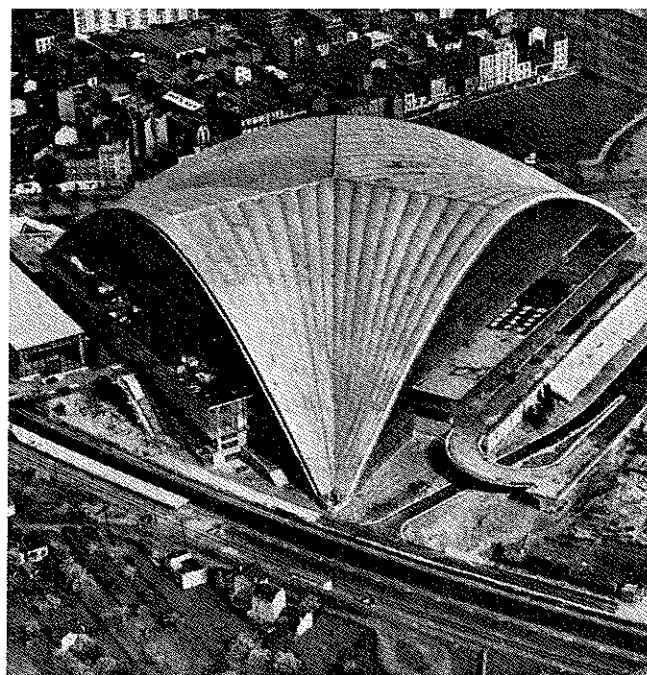
Fig 35. Trepunktsupplagt, armerat betongskal vid Rond Point de la Défense i Paris, basidlängd 218 m
