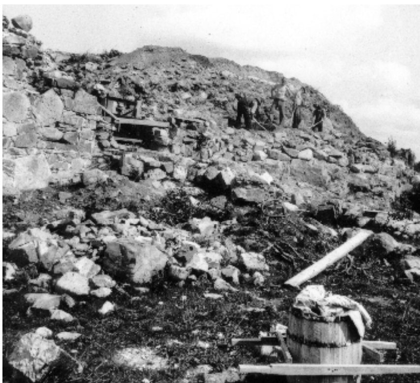
Fig. 9 Vid 1930-talets undersökning bestod arbetsstyrkan av beredskapsarbetare från trakten. Här är man i arbete med att rekonstruera borgplatåns ringmur. Foto Lars.Erik Bergström 1936. ATA A5:289.
