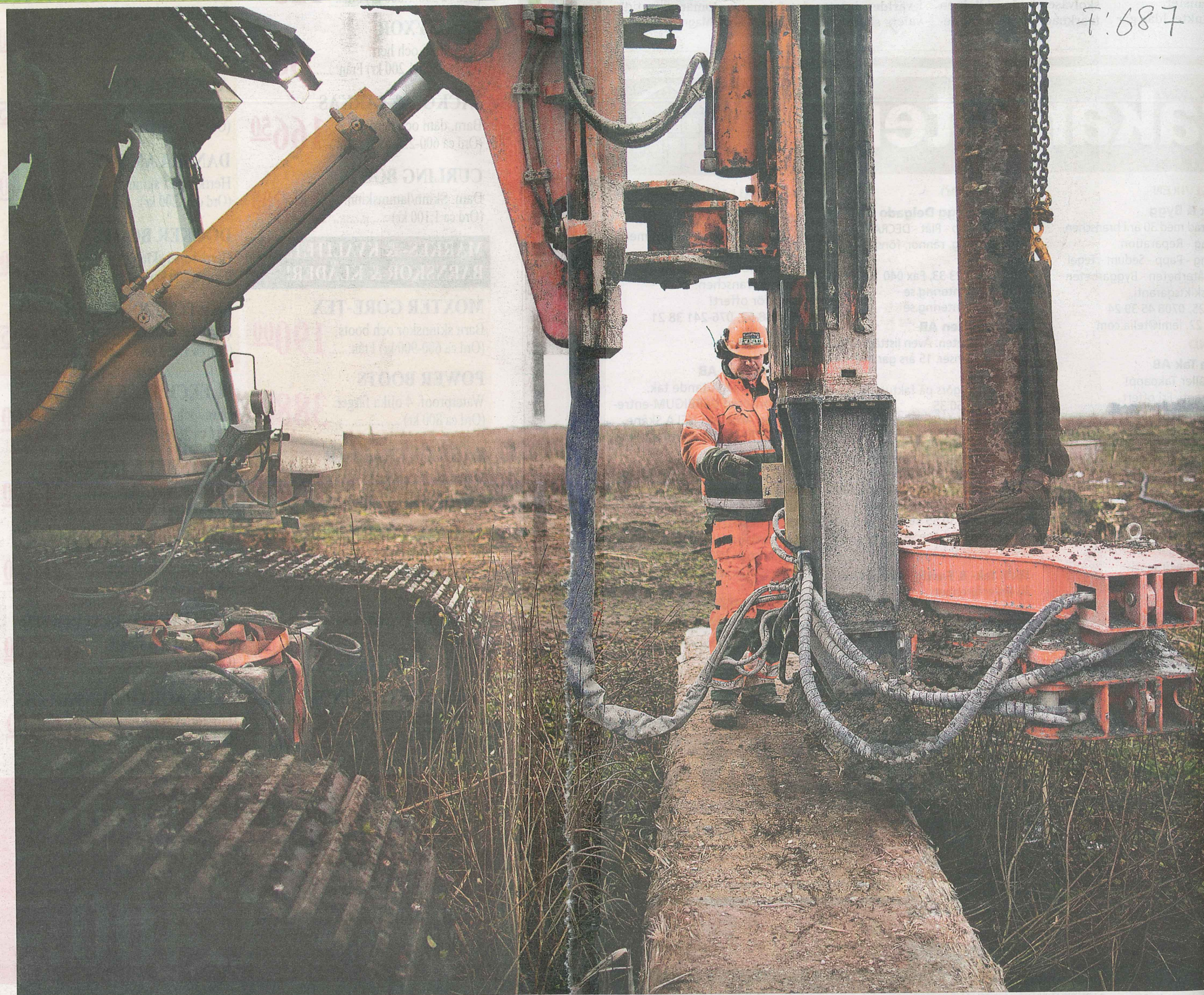
Fredrik Toresson styr pålningsmaskinen och ska nu slå ner en stälkärnpåle.
